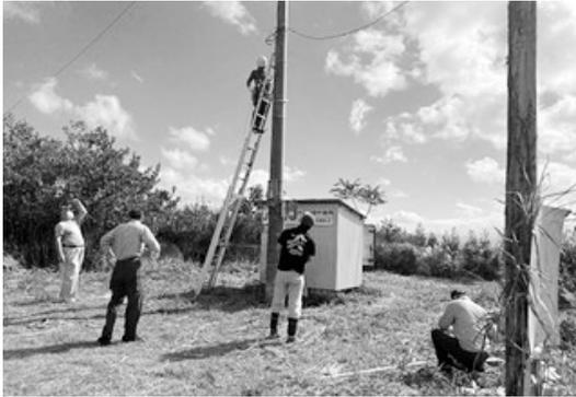
2021年10月10日「JARLレピータ(439.86MHz)鹿児島県伊佐市大口川岩瀬」のサービスエリアが狭くなっていたため(ANTのSWRの数値が高く), 新品ANTに取替作業を実施しました。稲刈り作業が進む田園を眺めながら, 午前中に大口レピータ管理団体メンバー局長JR6JTO丁野, JF6JFA末原, 中野さん, 鹿児島市内局長JA6MST福吉, JA6VDM橋口, JG6MNG松木, 日置市局長JA6NHN西の7名が集まって, お昼過ぎには作業が終わりました。現役時代の技でパンザマストに登って貰い, AHT準備やマストをロープで上げ下げ作業に力を合わせて頑張りました。準備備品(ロープ, 滑車, 3段ハシゴ, アナライザーなど)を各局が持ち合っの作業でした。作業に参加された皆さん無事に終えて, お疲れさまでした。
