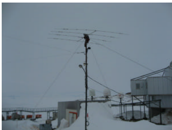
写真2：アンテナ方向修正作業
