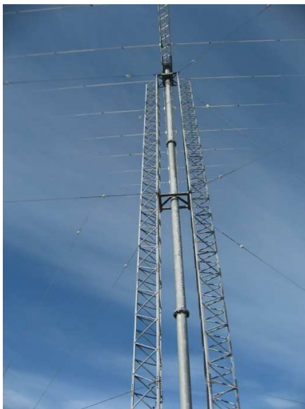
写真2：10エレメント、ログペリアン テナ搭載可倒式業務タワー
