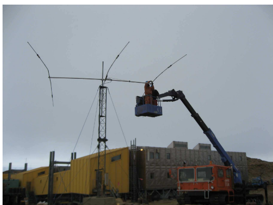
写真2：高所作業車を使用しアンテナ（10, 18, 24MHz帯用）の整備
