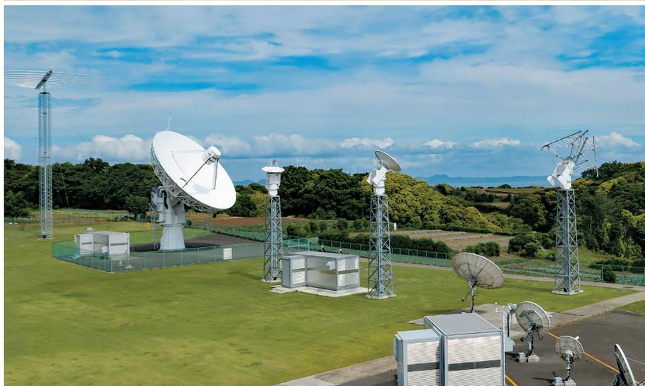
▲ 25,000平方メートルの広大な敷地に短波帯以下の監視用として10基のアンテナが設置されている
