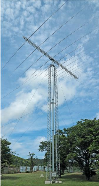
◀4～30MHzをカバーするログペリアンテナは3基ある。回転半径約15m、利得は8～11dB
