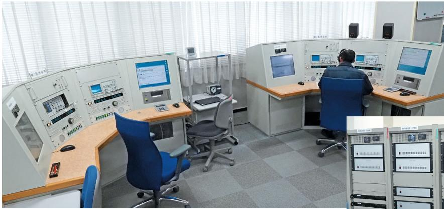
◀短波監査装置の操作卓は複数設置されている。A3EやJ3E電波だけでなく、印刷無線電信、狭帯域の画像、各種データ通信の復調、解読も可能
