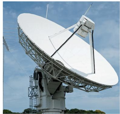
▶静止衛星の監視に使用する13m級パラボラアンテナ。敷地内に2基設置されている
