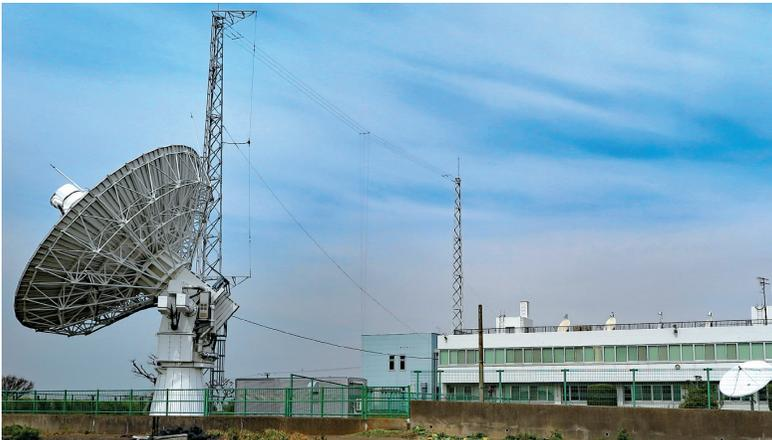
▲パラボラアンテナの後方にT形アンテナ(0.1～4MHz)、垂直ダイポール(7～9MHz)、傾斜形アンテナ(3～30MHz)がある
