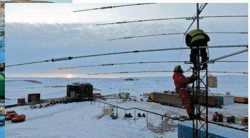
強風でアンテナが振り回されないようにビーム方向はJA向けに固定
