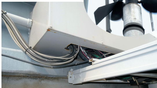
▲アンテナにつながる数多くの同軸ケーブルは、ビルのダクトを利用して室内に引き込まれている
