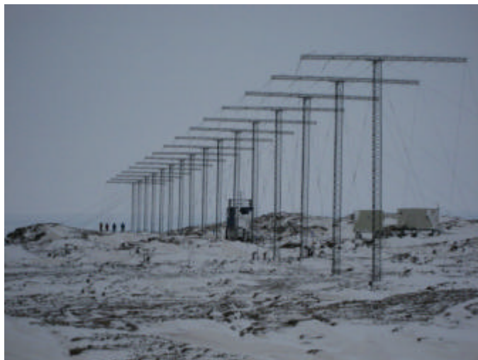
写真 2 : 16 基一式のログペリアンテナ群
