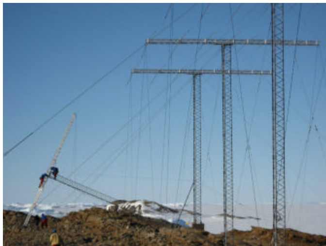
写真 1 : タワ - を倒して ログペリアンテナの保守作業
